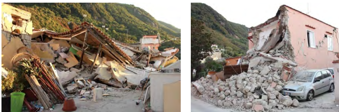
Figura 3.6-1. Casamicciola "Zona Rossa": crollo totale e parziale.
