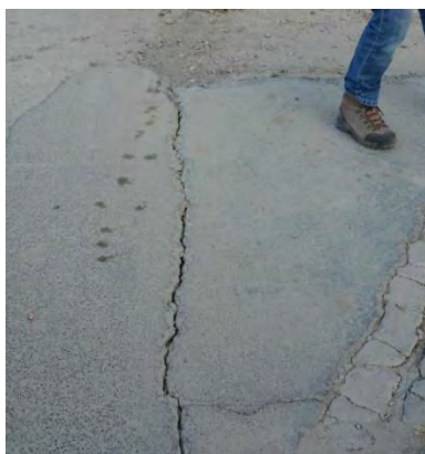
Foto 9. Frattura nell'asfalto.
