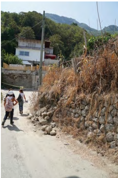
Foto 2. Fine evidenze crolli dei muretti a secco lungo una traversa di via S. Barbara, Casamicciola.
