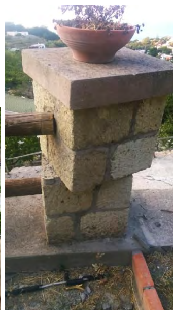
Foto 13. Frattura nel solaio di copertura e danni ai manufatti (a sinistra) con evidente rotazione di parte della colonna in mattoni di tufo (a destra).
