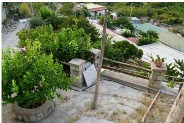
Foto 13. Frattura nel solaio di copertura e danni ai manufatti (a sinistra) con evidente rotazione di parte della colonna in mattoni di tufo (a destra).
